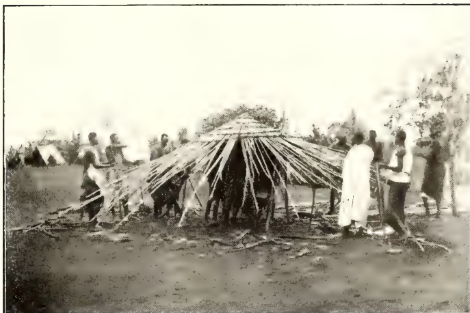
Abb. 356. Bau einer Waganda-Hütte (zweites Stadium). Einsetzen des Mittelpfeilers.
